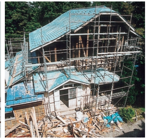
2001(平成13)年10月 青根セミナーハウス旧館解体中
