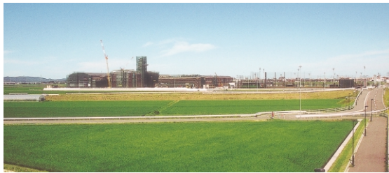
建設中の新キャンパス遠景
