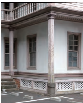
写真18 建物南東隅の独立柱
