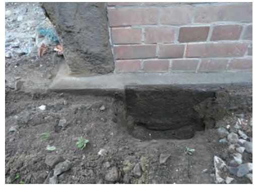
写真13 ペDESTAL状に加工された地覆（石束の下部）
