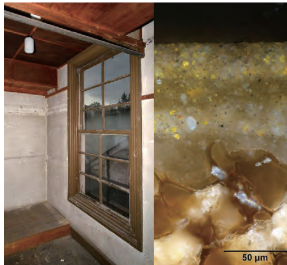
図13 二階倉庫建具の塗膜層(実体顕微鏡写真)
