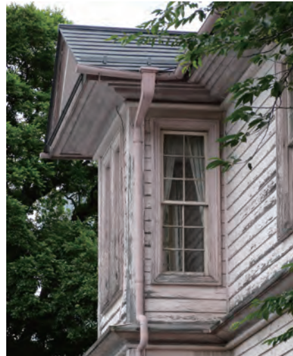
写真25 建物西面のベイウインドウ上部のペディメントと胴蛇腹
