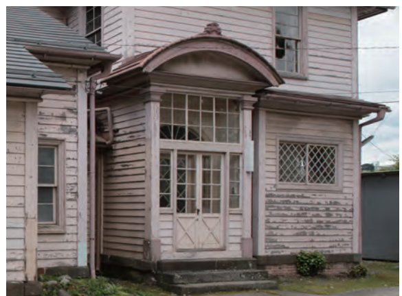
写真26 玄関屋根の処理
