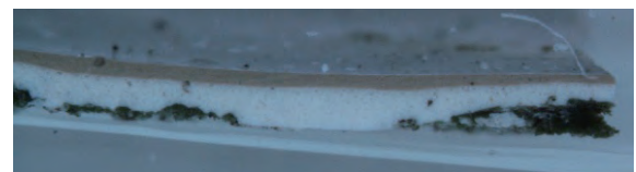
図5 外部柱の塗膜層(実体顕微鏡写真)
