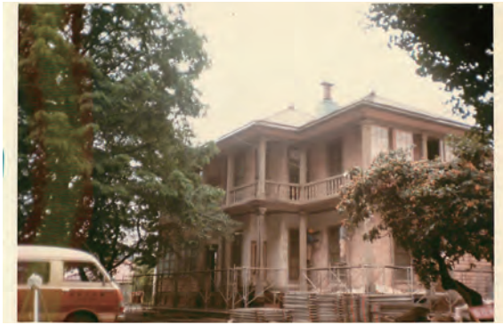
写真17 下見板の斜張りの状態が分かる
