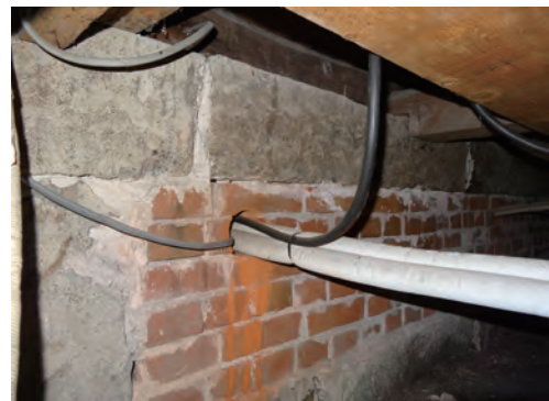
写真15 基礎の背面（手前にペDESTALの束が写る）
