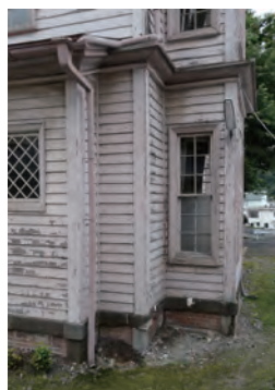
写真19 建物北西隅の付柱
