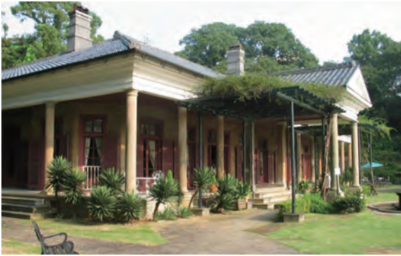
写真21 旧オルト住宅外観
