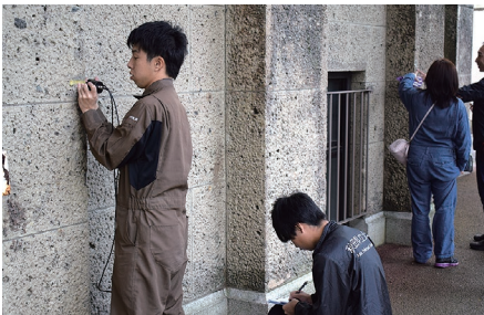
秋田県立大学による外壁調査の様子
