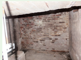
fig.2 地下に残る設備拡張用の 仮設レンガ壁
